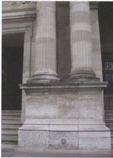
Fig. 5-15. La Cour Napoléon au palais du Louvre à Paris. Tambours de colonnes refaits en calcaire de Saint-Maximin (Oise), prenant une patine plus grise que les calcaires parisiens (photo A. Blanc).
