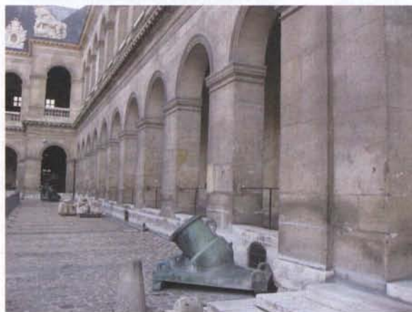
Fig. 5-13. Cour intérieure de l'hôtel des Invalides à Paris. Les piliers de la galerie sont constitués de gros blocs de calcaire à Ditrupe (carrières de Saint-Leu-d'Esserent) reposant sur des assises de calcaire à cérithes (carrières de Vaugirard) (photo A. Blanc).
