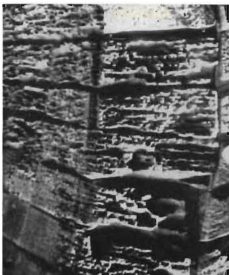
6. PONT DU GARD. — *Alvéolisation en zone humide par infiltration* (Cl. Krumbein).
