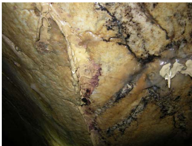
Taches mauves sur les élastomères
