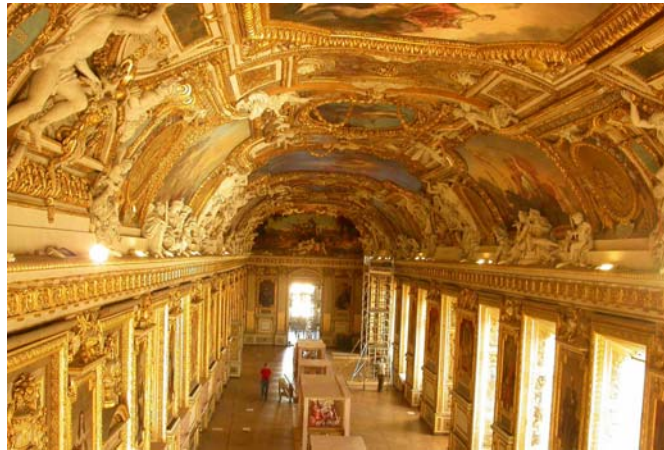
Photo de la galerie d'Apollon pendant les travaux de diagnostic
